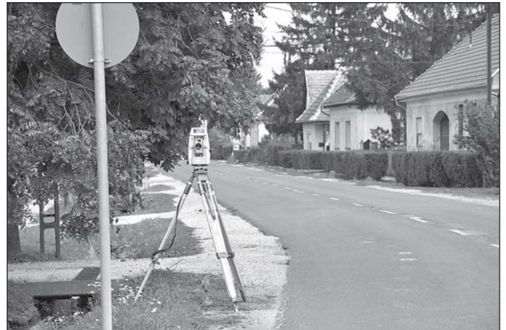
Állapotfelméréssel elkezdődött az Etyek – Alcsútdoboz közötti közút felújításának tervezése.
